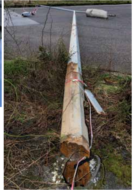
Bleibende Deformation an einem Beleuchtungsmast – mit mastap wäre das nicht passiert.
